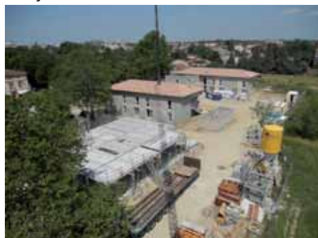
Les deux foyers et le réfectoire en construction
