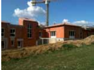
3 ème foyer en construction
